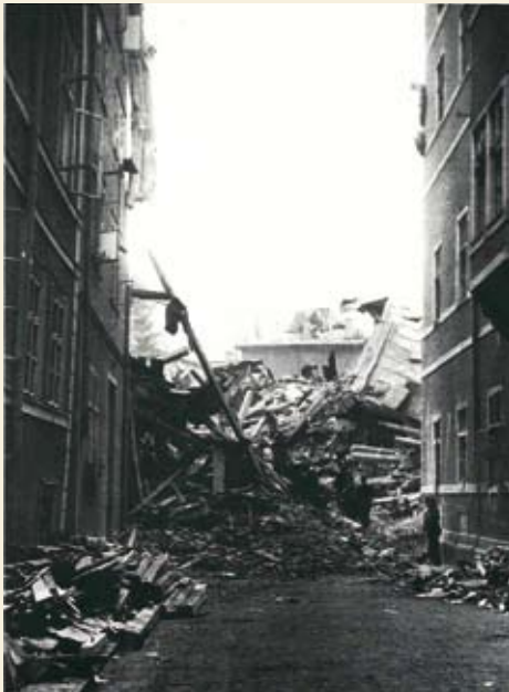
Blick von der Kapittelgasse Richtung Kaigasse. Das Haus Kaigasse 10 (links am Ende der Kapittelgasse) wurde total zerstört.
