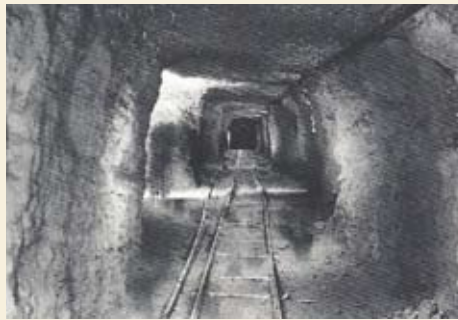
Errichtung von Luftschutzstollen
