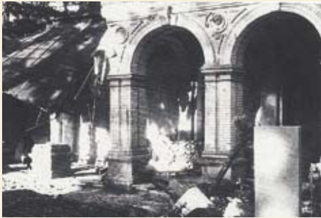
Kommunalfriedhof - schwere Schäden an den Arkadengrüften
