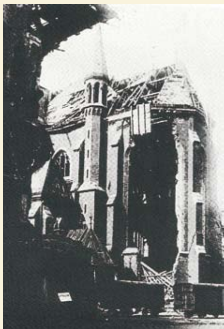
Andräkirche, am 27. 2. 1945 zum zweiten Mal bombardiert und schwer beschädigt
