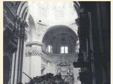
Wie durch ein Wunder entstehen im Inneren kaum weitere Schäden
